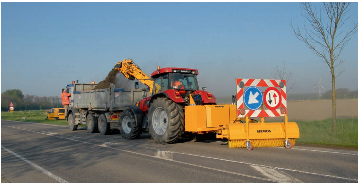
Een Hemos-bermschaaf-laadcombinatie.
